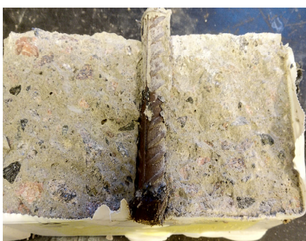
Bild på provkropp efter spräckning med genomgående armering, efter vattentäthetsprovning. Ingen synlig fuktinträning. Tyvärr visas en mörkare yta skapad av skuggan från kameran.
