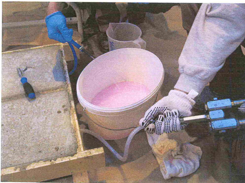
Bild 6 Durchgängigkeit des 30 m langen, einseitig injizierten Injektionsschlauches
