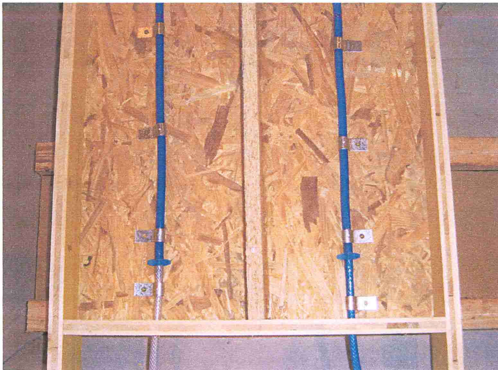
Bild 2 Übergang Injektionsschlauch - Verpressenden
