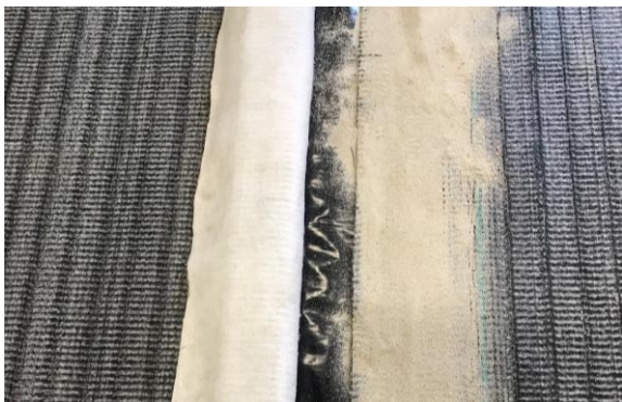
Vik tillbaka en av bentonitmattorna. Strö lös bentonit där mattorna läggs omlott.
