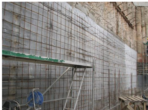
HyDra Tex monterad i form för fastgjutning
