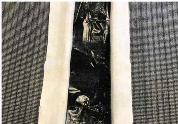
Vik undan bentonitmattorna, lägg plasten omlott.
