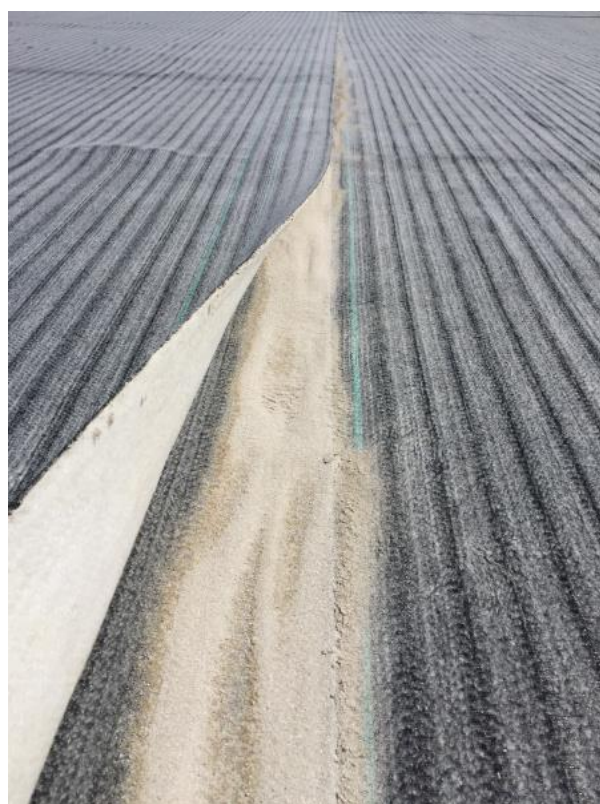
Strö bentonitpulver i överlappen
