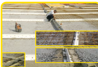
K-Form asennettuna 150 mm:n betonilattiaan
